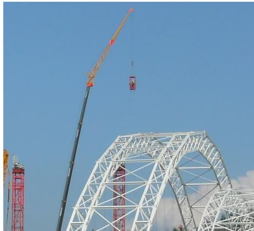
Bild 1: Eine sichere Alternative zu einer 85 m Kletterpartie zum Fachwerkknotenpunkt des Bogentragwerks ist der Ein- und Ausstieg aus einem Kran-Arbeitskorb
