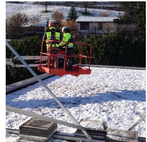
Bild 2: Erreichen eines hochgelegenen Arbeitsplatzes mittels Hubarbeitsbühne
